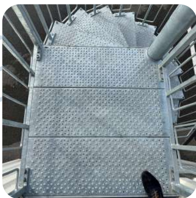
Palier de sortie environ 1m 2
